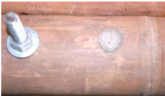
FOTOGRAFIA N° 8. Perforación para inyección del mortero.
